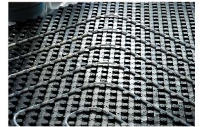
Fußbodenheizung
