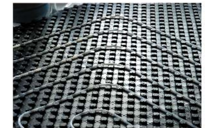
Fußbodenheizung
